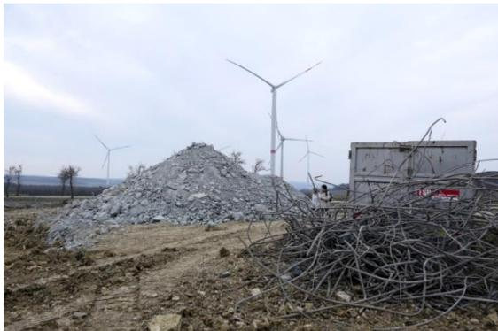
März 2024. Fundamentbeton und Stahlarmierung einer alten Anlage nach Aushub bereit zum Recyclen.
