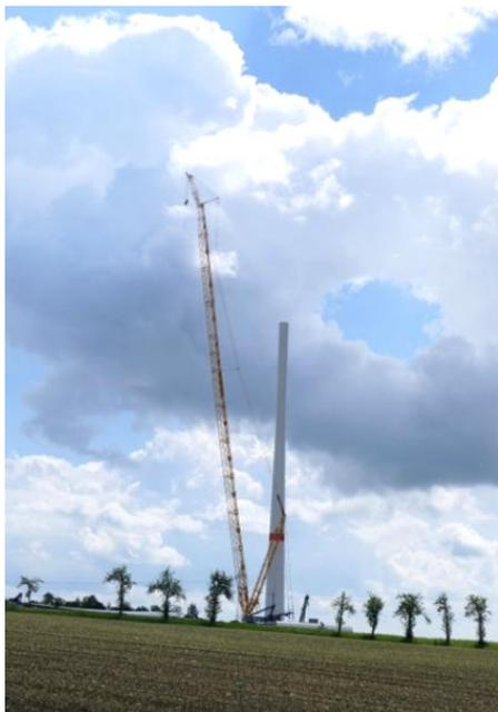
Mai 2024. Über 200 m hoch ragt der Kran, der eine der 164 m hohen Nordex-Anlagen fertig montieren wird.
