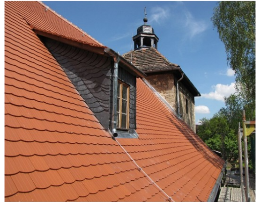
Außenansicht des neuen Kirchenschiffdaches mit denkmalgerechter Biberschwanz-Doppeldeckung, verschiefelter Gaube, Dachentwässerung, Turmanschluss und Blitzschutz; Im Hintergrund ist das sanierungsbedürftige Turmdach zu sehen.
