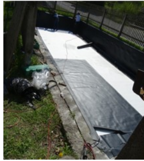
Auf die weiße Dichtungsfolie wird eine schwarze aus zugfestem Material bestehende Folie geklebt (17.04.2019).
