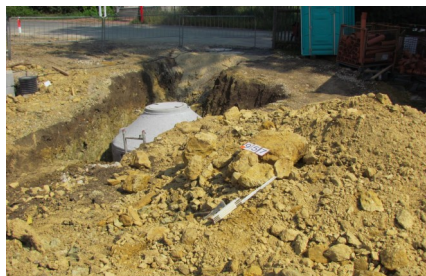
Abb. 6: Beim Aushub dieses Grabens wurden Dolomite ange-
