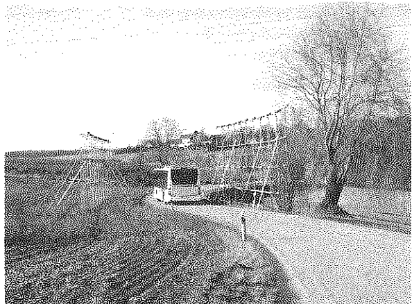
Abb. 1: Das Schutz-Gerüst an der Straße nach Lützeroda.
