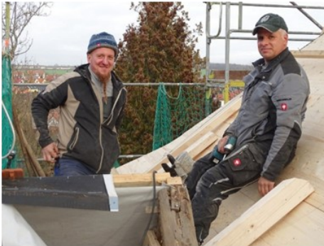
Die Zimmerleute Heiko Penzel und Uwe Neudel (Fa. DEBAS/Plauen) machen eine kurze Fotopause bei der Arbeit am Übergang vom Turm- zum Schiffdach..
