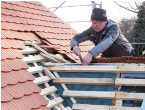
Dachdecker Mike Hoffmann (Fa. Dinger/Linda) bei der kunstvollen Gestaltung des Übergangs von Schiff- und Turmdach, mit nach oben auslaufendem First und eingebundenen Bieberschwanzkehlen
