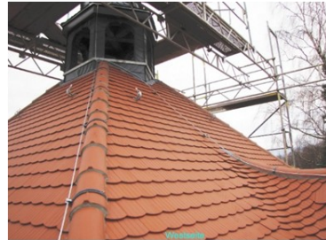
Die Nord- und Westseite des neuen Turmdachs mit geraden Linien, ebenen Flächen und exakt verlegten Ziegel. Die Übergänge zur Laterne und zum
