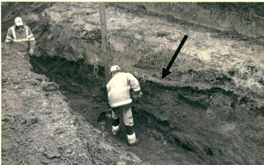
Abb. 1: Graben östlich des Regenrückhaltebeckens in dem gerade die Schmutz- und Regenwasserableitungsrohre verlegt worden sind. Der Pfeil markiert ein Lettenkohlenflöz.
