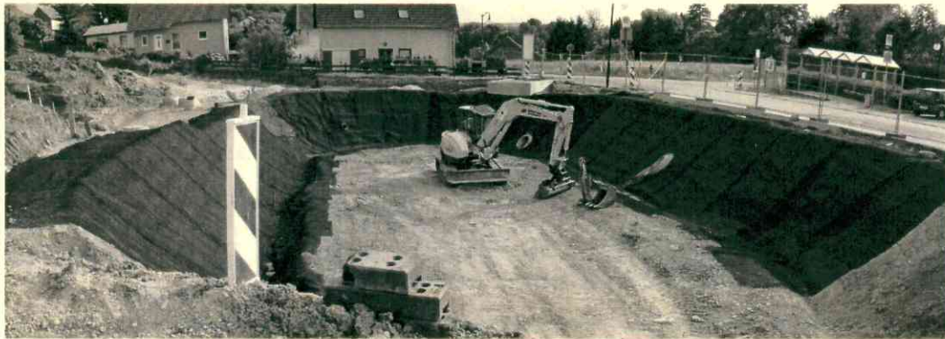
Abb. 4: Das Regenrückhaltebecken im Bau. Auf die speziell rutschungsgesicherten Böschungen ist ein schwarzes Kunststoffgewebe aufgelegt. Es wird wie fast das gesamte Becken mit Mutterboden überzogen und begrünt.
