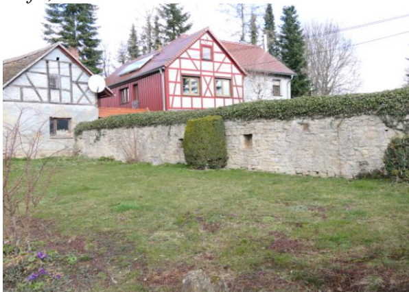
★ Alte Kalksteinmauer in „Wunbergers Hof“, Nordseite.
