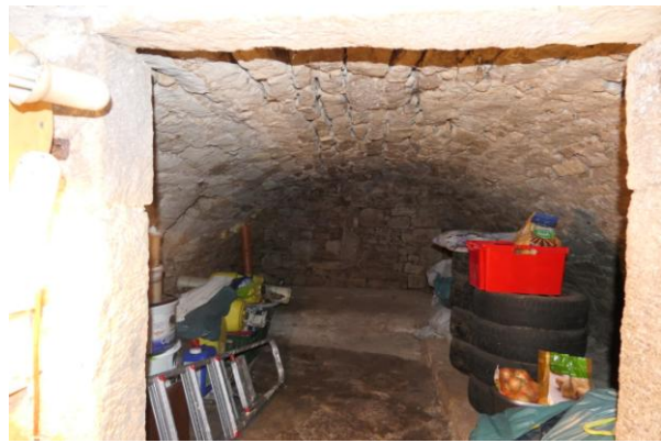
★ Einer der beiden gut erhaltenen Gewölbekeller unter dem Wohnhaus .
