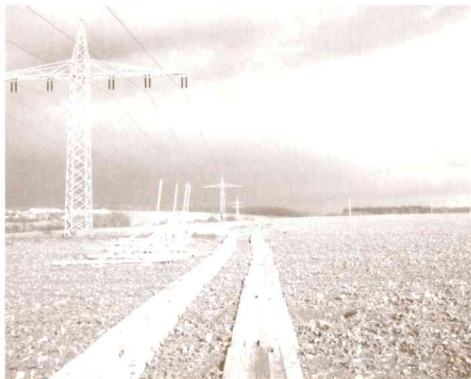
Abb. 1: Die Mastenstandorte sind auf dem durchweichten Ackerboden nur über Bohlenwege zu erreichen.
