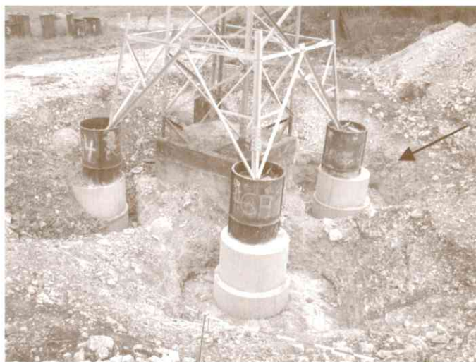
Abb. 2: Um das Fundament eines alten Stahlfachwerkmastes sind schon Teile der Einzelfundamente des neuen Mastes zu sehen. Der Pfeil markiert die Lage eines geologisch interessanten Harnischs (Abb. 3).
