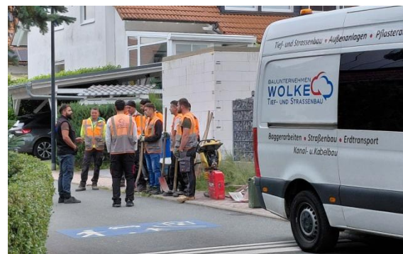
Arbeitsbesprechung der Kabelverlege-Brigade von Firat Abkulut im Schlehdornweg.
