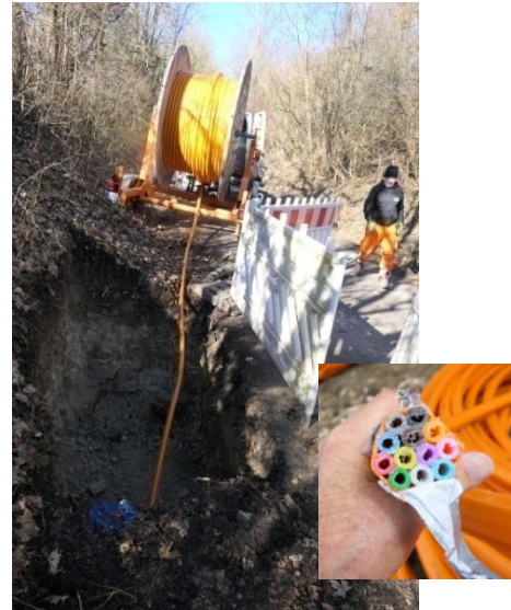
Zug um Zug wird der gelbe Plasteschlauch durch das Horizontalbohrloch mit 140 mm Durchmesser gezogen. Das Ausschnittbild zeigt zwölf Einzelleerrohre im Hauptstrang, durch die später die einzelnen Glasfaserstränge eingeblasen werden.
