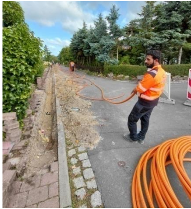
Beim Verlegen des Hauptstranges im Fußweg des Mühlenweges
