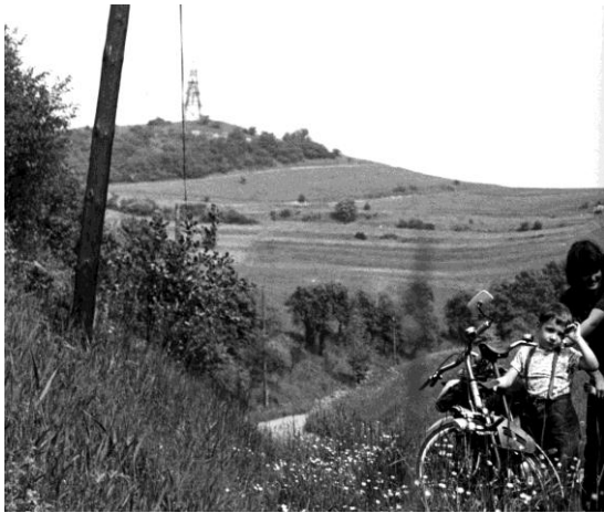
Abb. 3.11: Blick vom Cospedaer Grund auf den Windknollen mit hölzernem TP-Turm. (1980).
