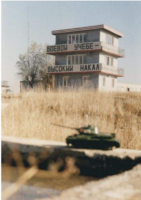
Abb. 3.14: Kommandoturm, im Dorffargon „Kreml“ genannt, dessen Transparent auf die Wichtigkeit hoher Gefechtsbereitschaft hinweist (Foto Dr. KARSTEN GNEIST, Jena).
