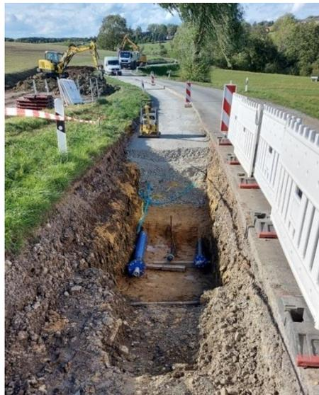
Blick in den Leitungsgraben während der Verfüllung und Verdichtung. Die Leitungsstränge v.r.l. Trinkwasserleitung, Datenkabel-Leerrohr, Abwasserleitung.
