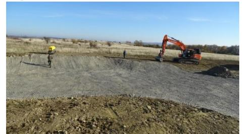
Abb. 2. Nov. 2018. Das Ton-Mischsubstrat der Beckensohle wurde mit einer Schafffußwalze verdichtet, anschließend mit einer Baggerschaufel geglättet und mit einer Kalksteinschotterdecke versehen.
