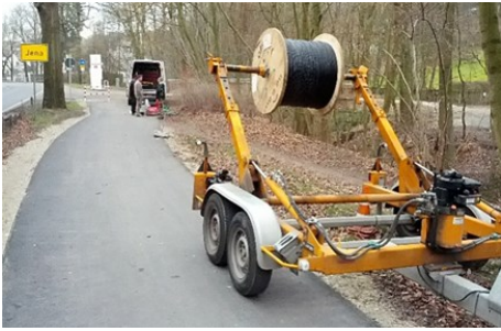
An der B7 Ortseingang Jena. Hier wird gerade ein Glasfaserkabel von der Trommel im Vordergrund abgewickelt und in ein Leerrohr mit bis 15 Bar Überdruck gepresst. Ziel: die etwa 2,7 km entfernte Hauptpost (Febr. 2014).
