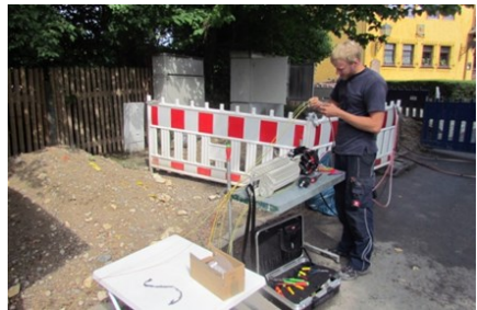
Ein Telekom-Fernmeldetechniker bestückt eine Glasfasermuffe, die erdverlegt wird. Die von ihr ausgehenden Kabel werden im darüber liegenden Verteilerkasten mit den Kupferkabeln der Endverbraucher verbunden (Juli 2014)
