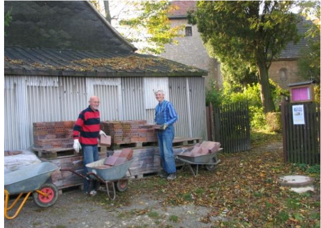
Die neuen Fußbodenplatten aus Kraftsdorf werden in die Kirche transportiert (18.11.06).
