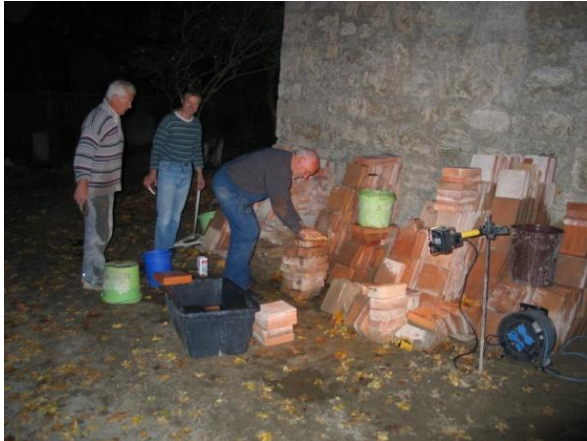
Im November nach Feierabend. Säubern der ausgebauten Fußbodenplatten im Flutlicht.
