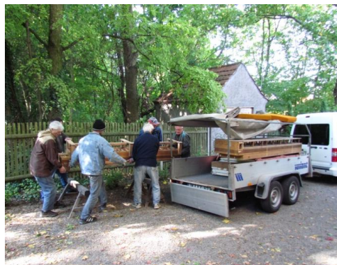
Abbau der Orgel und Verladen schwerer Teile für den Transport in die Stadtilmer Orgelbau-firma Schönefeld.
