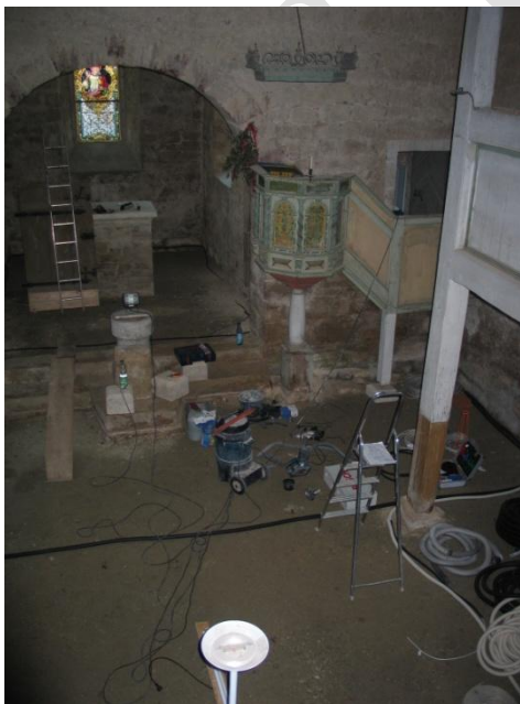
Einbringen der Frostschutzschicht und Verlegen der Fußbodenplatten durch Mitarbeiter der Fa. Canzler.
