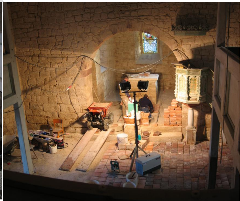
Einbringen der Frostschutzschicht und Verlegen der Fußbodenplatten durch Mitarbeiter der Fa. Canzler.
