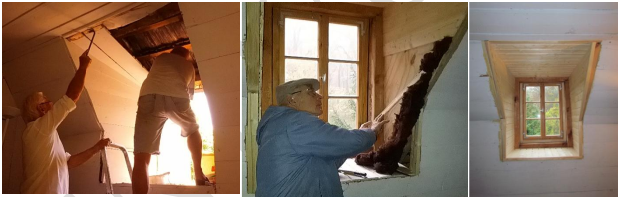
Das Lösen der alten Bretter eine staubige Angelegenheit.- Die Hinterfüllung der neuen Verschalung erfolgt denkmalrechtgerecht mit unbehandelter Schafwolle.
