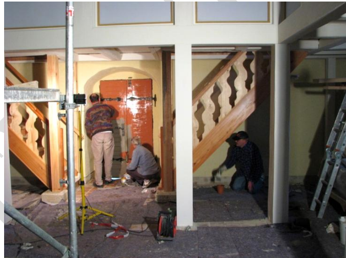
FCK-Einsatz am 03.11.07: Die Türen werden gestrichen und das Treppengeländer grundiert.
