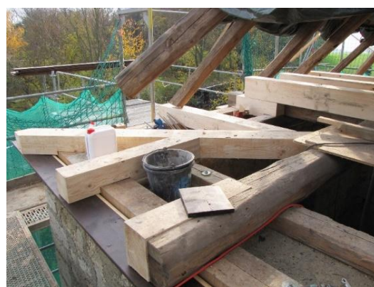
Sanierung der Mauerkronenebene des Kirchturms. Die drei Überzugbalken im Hintergrund bilden eine vorteilhafte Alternative zu der alten Konstruktion.
