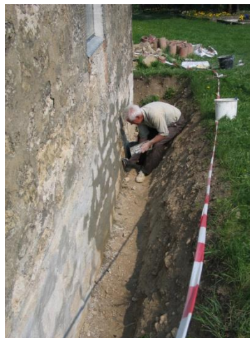
Verfugen der ausgekratzen, gesäuberten Mauerwerksfugen mit Rajasil Fugenmörtel.
