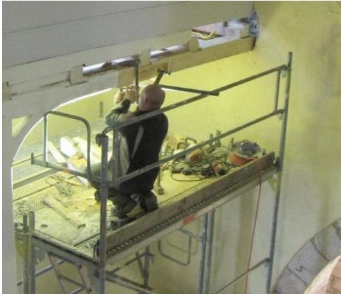
Präzisionsarbeit beim Zuschnitt und Einbau neuer Balkenteile am turmseitigen Auflager des Tonnengewölbes.
