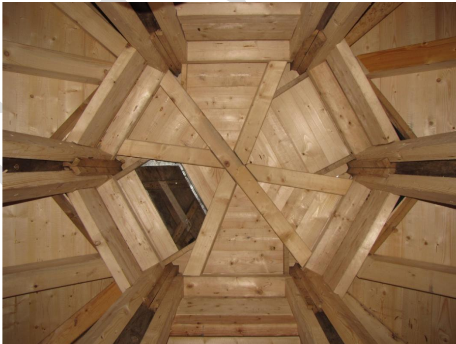
Die neue Rosette in der Glockenstube, eine zimmermännische Meisterleistung. Hoffentlich wird sie von den Fledermäusen ebenso wahrgenommen.
