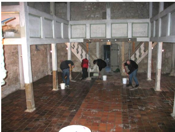
Beim Schruppen des neu verlegten Kirchenfußbodens.
