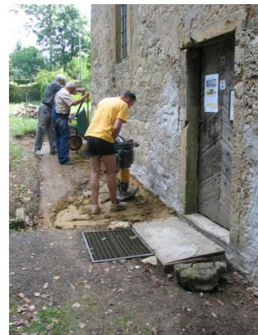
Verdichten der mit bindigem Lockermaterial verfüllten Mauergräben.
