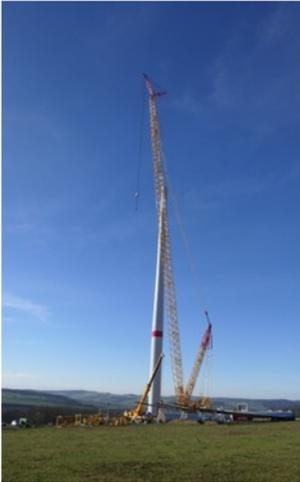
*Schätzungsweise fast 200 m ragt der Kran empor, der den schlanken Schaft Segment für Segment wachsen lässt. (24.11.2020) Im Laufe eines Vormittags werden die drei Rotorblätter an der in 166 m Höhe befindlichen Nabe montiert.*
