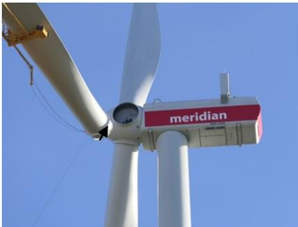
*In schwindelnder Höhe warten schon die Monteure, (👈) das mm-genau einfahrende dritte Rotorblatt verschrauben zu können. (18.12.2020)*
