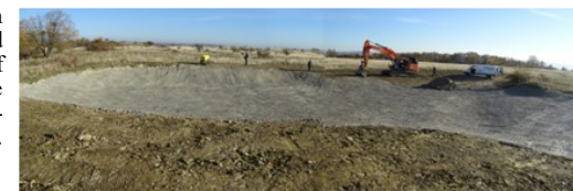
Nov. 2018. Die Beckensohle ist mit einer zweilagigen Ton-Mischsubstratschürze ausgekleidet.
