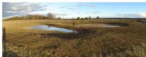
Nov. 2018. Die Beckensohle ist mit einer zweilagigen Ton-Mischsubstratschürze ausgekleidet.
