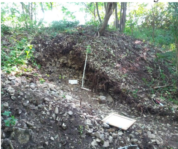
4.1-13 Walleinschnitt, ca. 25 m westlich Messpunkt A0
