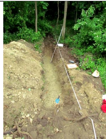
4.1-11 Baggerschlitz BS 2 . Blick von N in Richtung Wall
