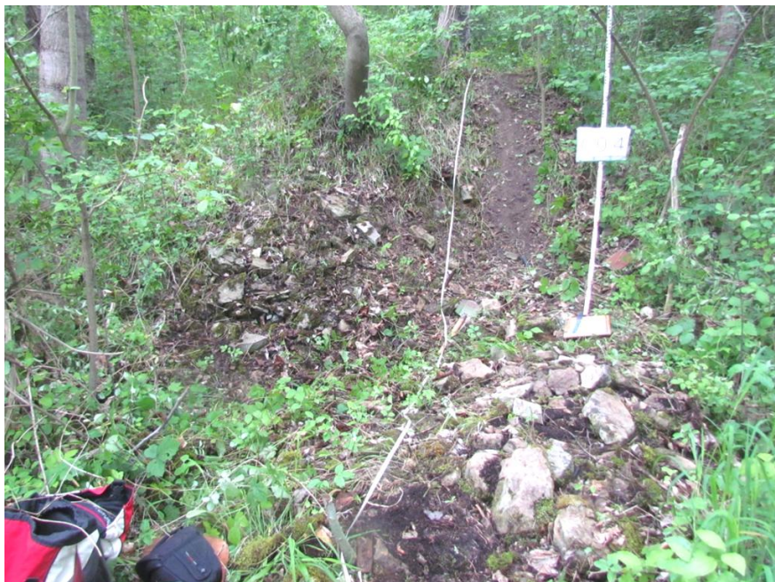
4.8-5 Vorwiegend aus Erdstoff bestehende Böschung des Profilabschnittes ⑤
