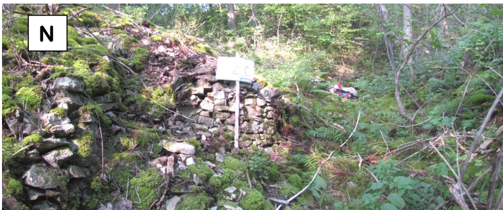
4.7-3. Stütz-Trockenmauer im ES A, 14 m westlich der Steinbruchwand. Blick nach Osten.
