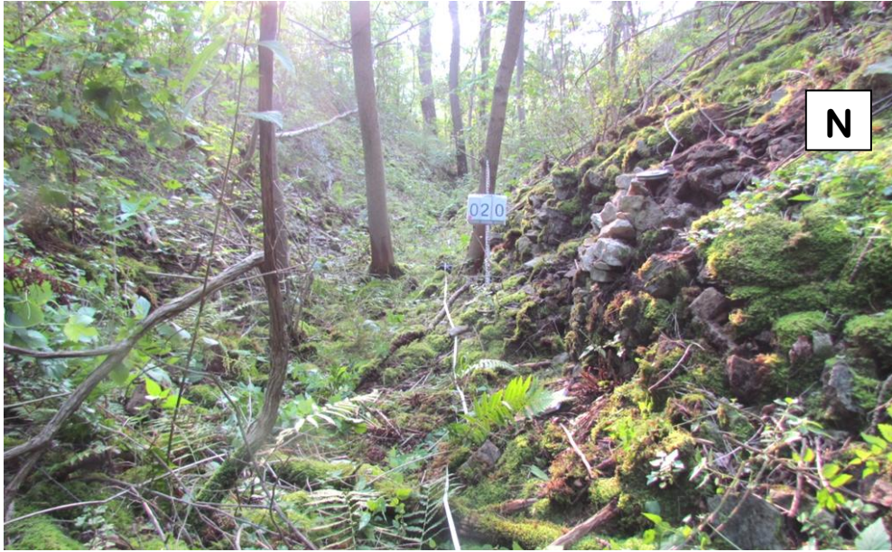
4.7-4 Stütz-Trockenmauer im ES A, 14 m westlich der Steinbruchwand. Blick nach Osten.
